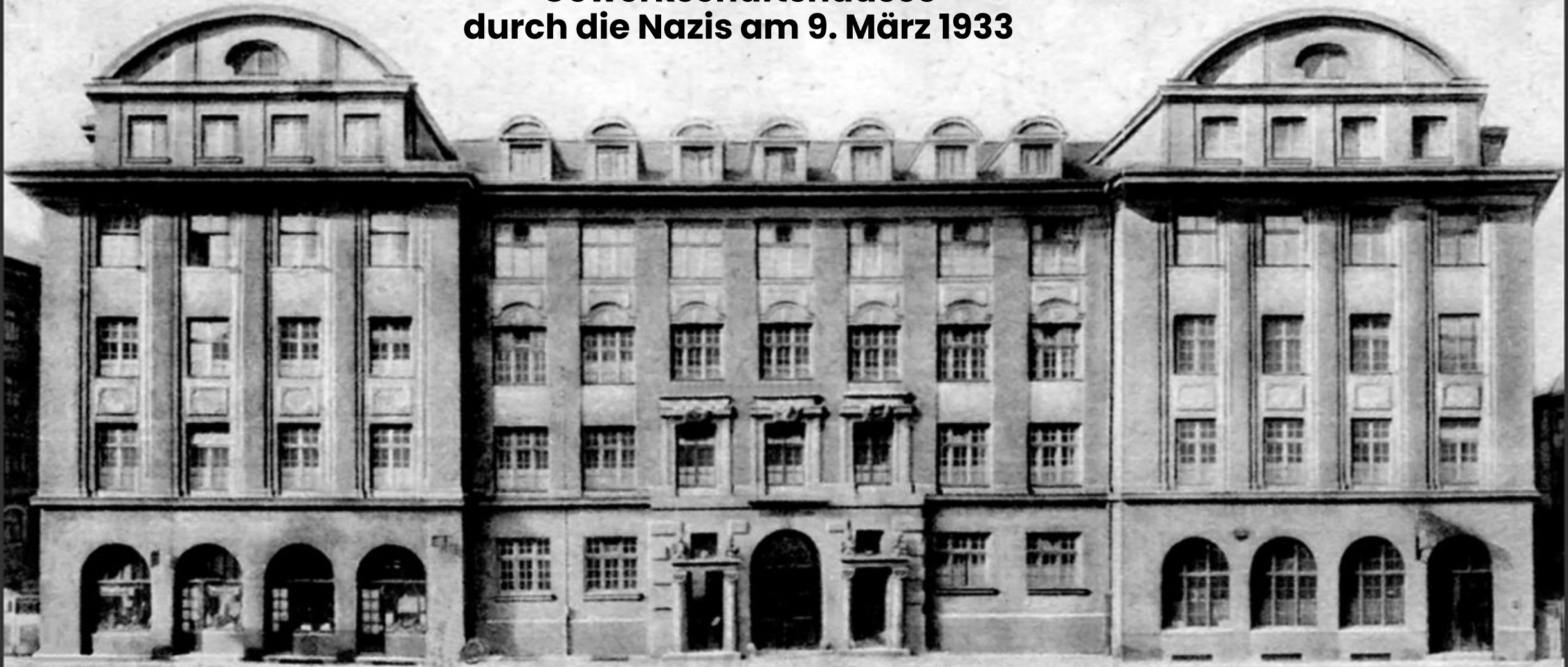
Gewerkschaftshaus (1912 bis 1933) in der Pestalozzistraße 40/42
